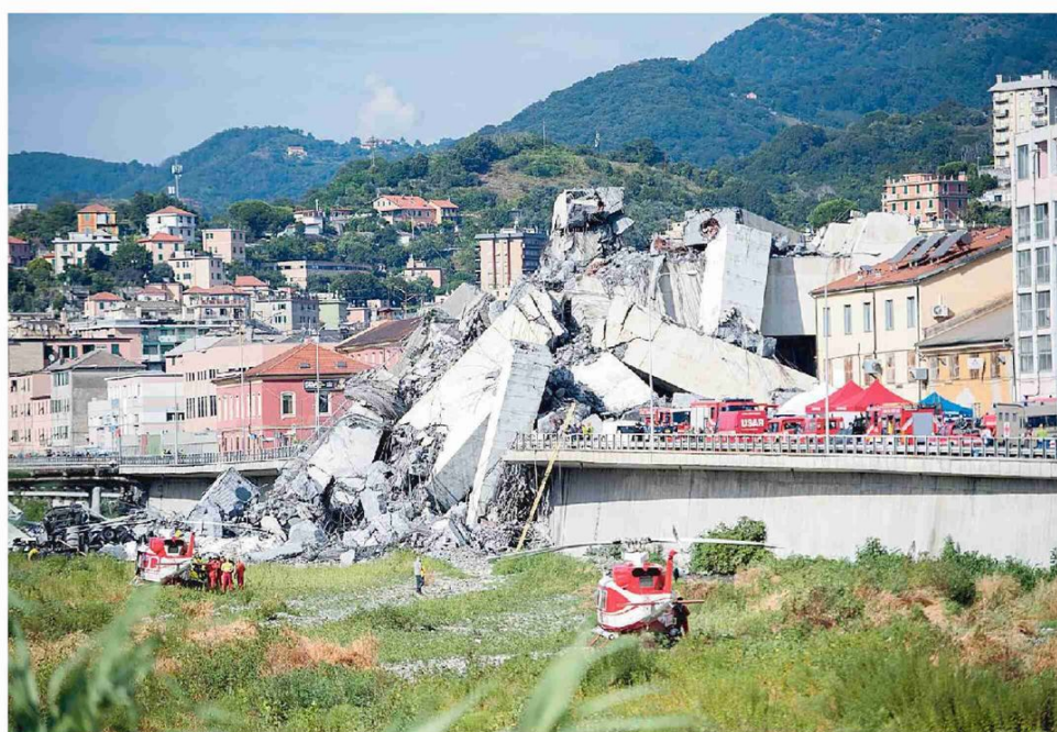
Il ponte Morandi subito dopo il crollo avvenuto la mattina del 14 agosto 2018: i soccorsi tra le macerie nel torrente Polcevera
